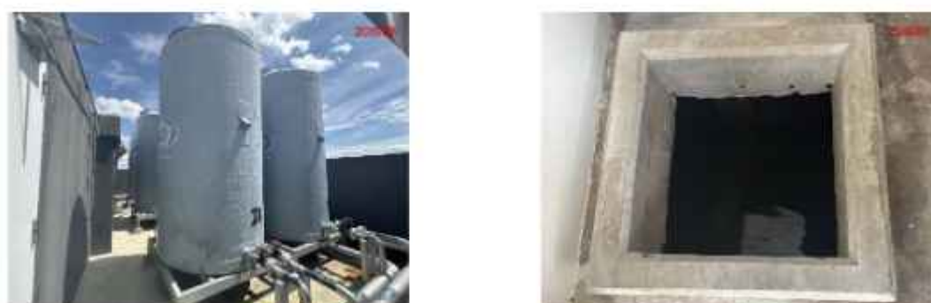
ภาพที่ 2.2-9 ถังเก็บน้ำสำรองชั้นตาดฟ้าและชั้นใต้ดินของโครงการ
