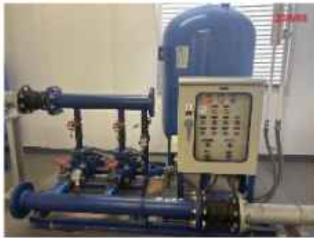
ภาพที่ 2.2-10 ระบบสูบน้ำประปา
